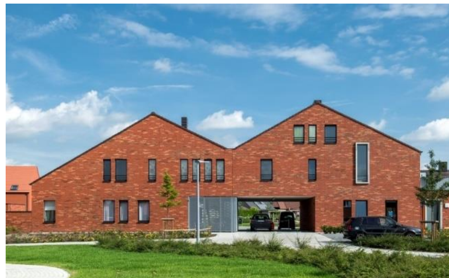
Figuur 88: voorbeeld van gebundelde fietsenstalling geïntegreerd in de bebouwing 44
