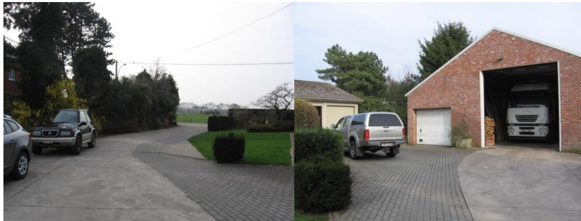
Figuur 11: Chapewerken Geerts. Links: zicht vanaf oprit in westelijke richting; rechts: zicht op bedrijfshal.
