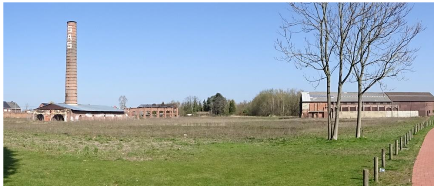
Figuur 14: zicht op ringoven, schouw en productiegebouw vanaf hoek Hoge Heideweg en Sint-Jozef (april 2019)
