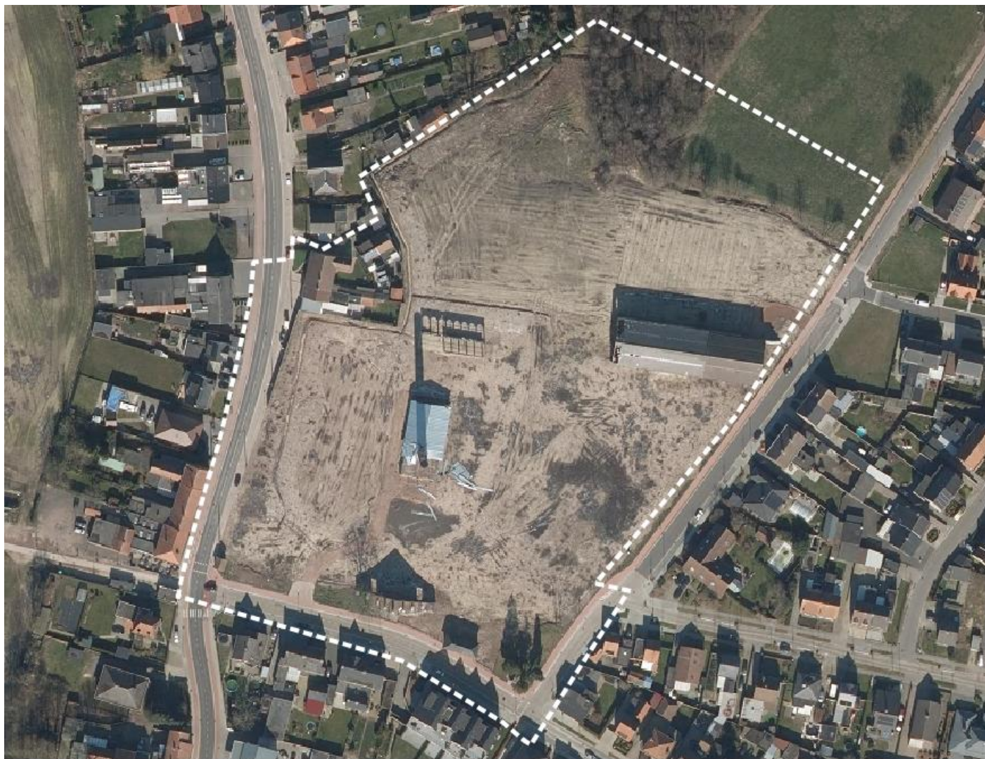
Figuur 2: orthofoto 2018 (na uitvoering sloopwerken)
